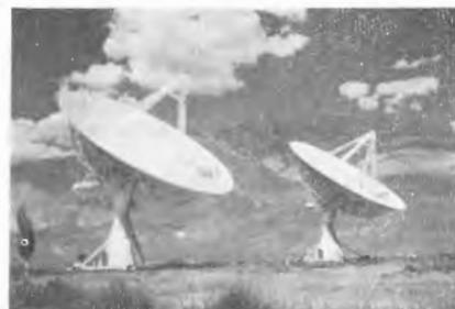
Fig. 17 - Interferometro a spaziatura variabile con 2 antenne da 27 metri della Owens Valley (altre 6 sono in costruzione).
